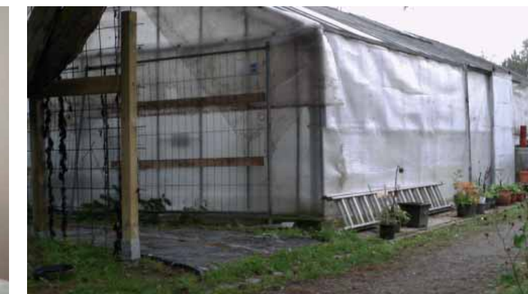
Hier entsteht der neue Biomeiler
