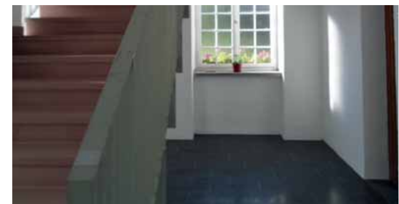
Das neue Fluchttreppenhaus
