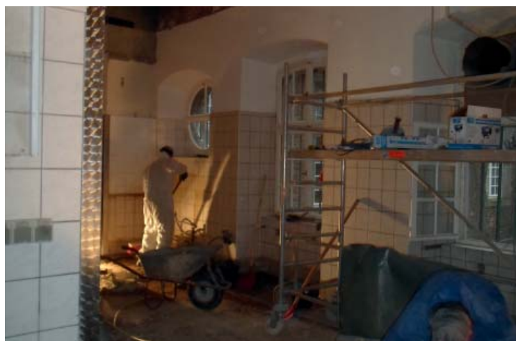
Hier entsteht die neue Küche
